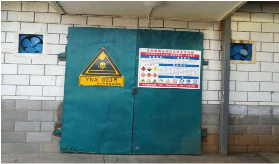
危废暂存间照片
